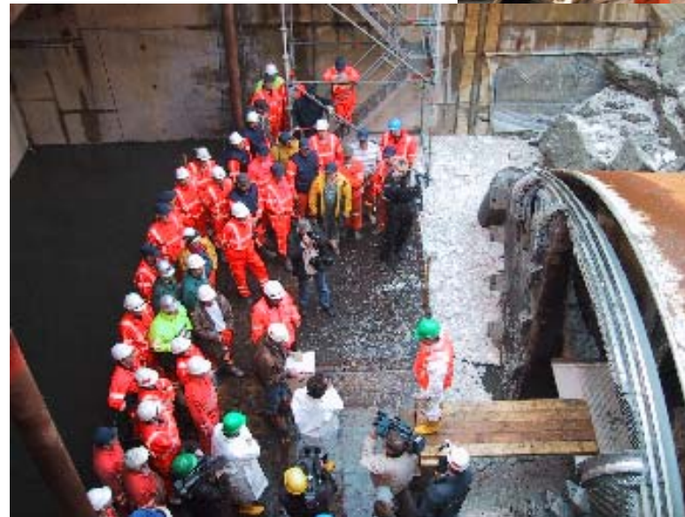
Đích đến của máy đào hầm TBM
